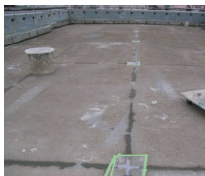
目地処理の施工例
