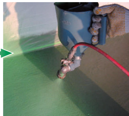
4 仕上塗料吹付け
