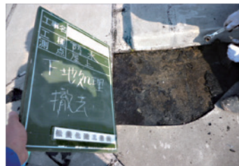
下地処理(ふくれ部撤去)
