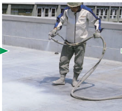
3 防水材吹付け(1回塗り)
