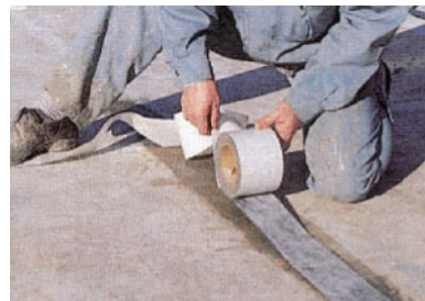
アロンゴムシートテープの張付け
