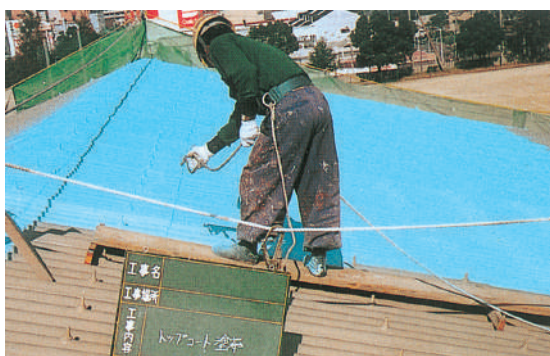
上塗材吹付け
