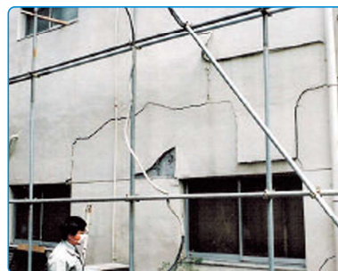
アロンウオール塗布外壁の状況
