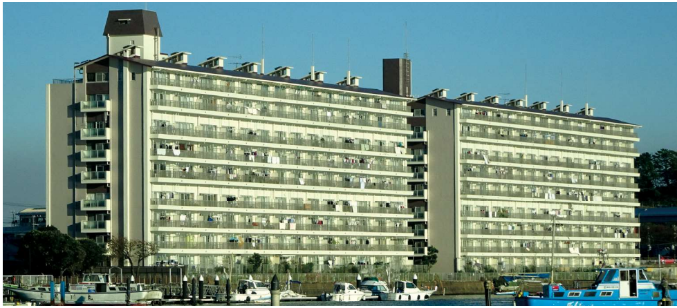
金沢八景ハイム (アロンウオールリフレッシュ工法 RA-STM工法)
