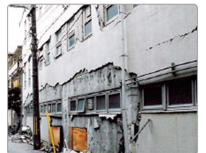
一般的な外壁の状況
