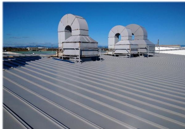
施工例(折板屋根)
