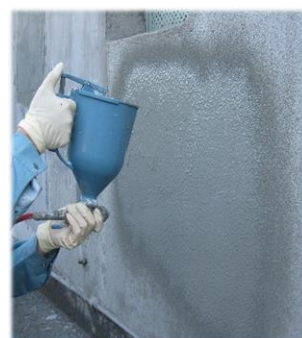
施工状況(吹付け)
