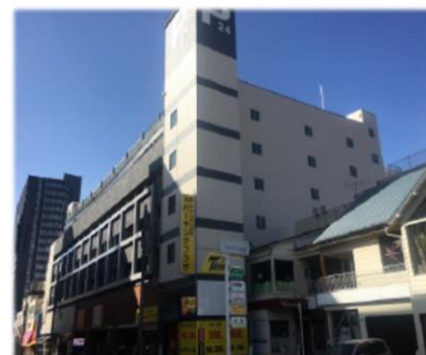
NEO工法 (立体駐車場)
