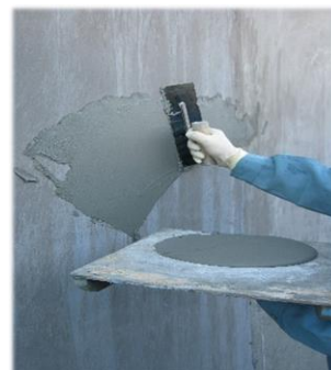
施工状況(コテ塗り)
