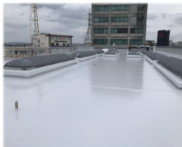
SQ-S工法施工例(既存:塗膜防水)
