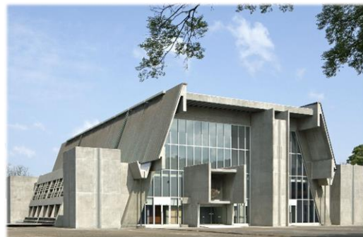
施工例(クリヤ工法)
