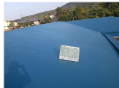
SQ-K工法施工例 (既存:アスファルトシングル葺き)
