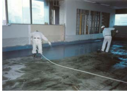
中塗材吹付け
