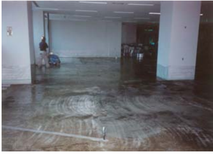
プライマー塗布
