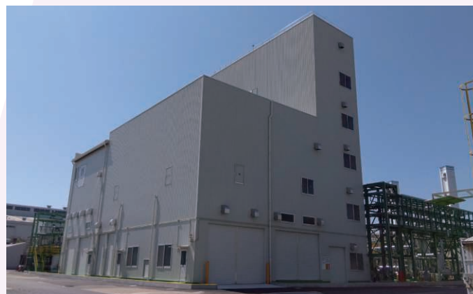
横浜工場 高純度液化塩化水素 新設備
