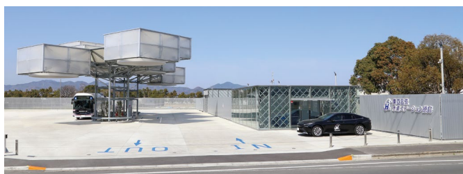
Estación de hidrógeno de Toagosei en Tokushima
