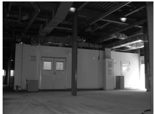
写真1 クリーンルーム外観
